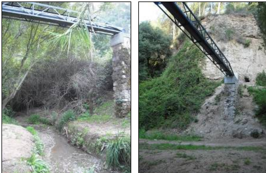
Imatges 16 i 17. Zona on s'ha fet l'arranjament de la canalització de reg.
