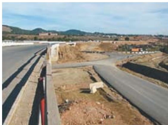
© Les obres de la Ronda Vallès a Terrassa. || JÚLIA PÉREZ/ACN.
