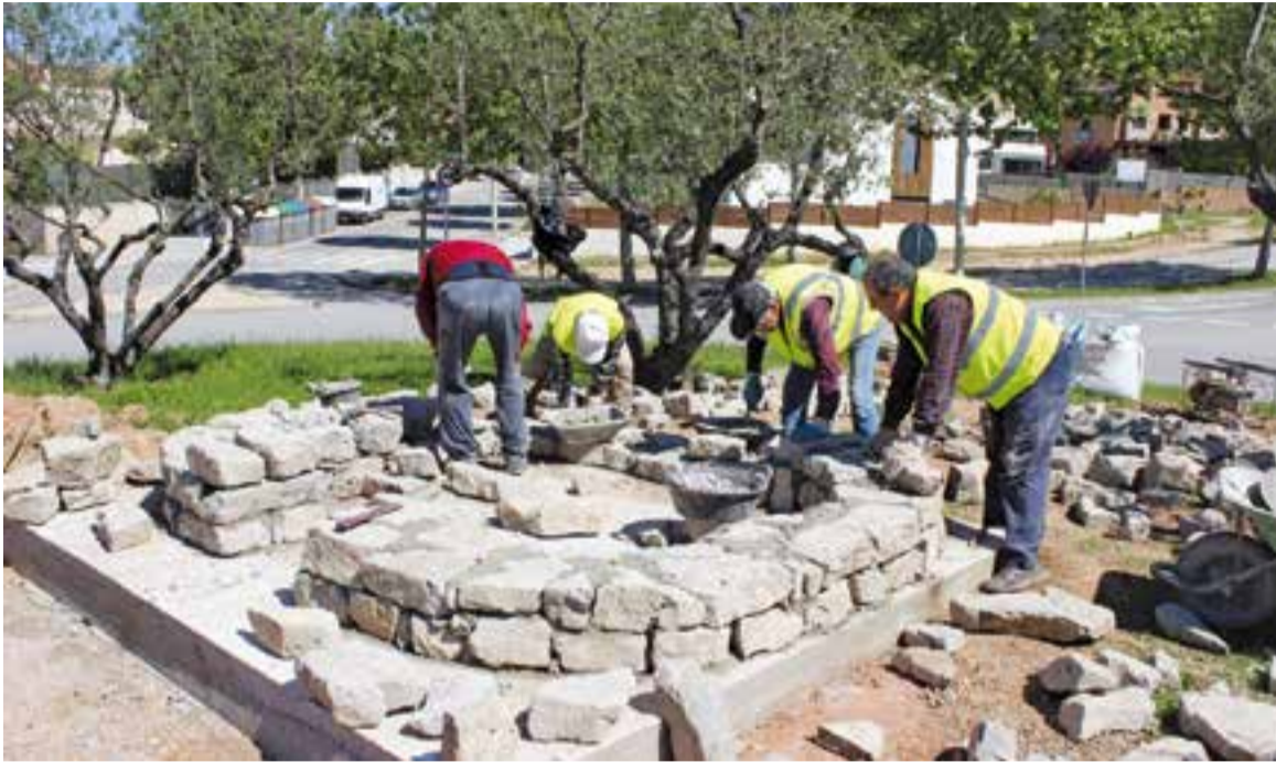
Quatre membres del Grup Pedra Seca treballen en la construcció de la barraca, que es vol inaugurar per Festa Major. || CEDIDA
