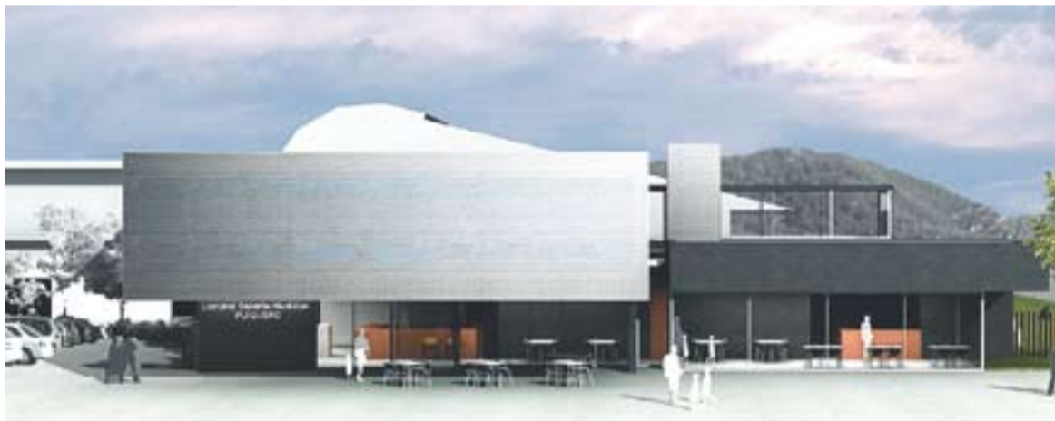
© Una simulació del nou edifici i la cafeteria del complex Puigverd vista des del carrer País Valencià, al costat de l'entrada actual.
