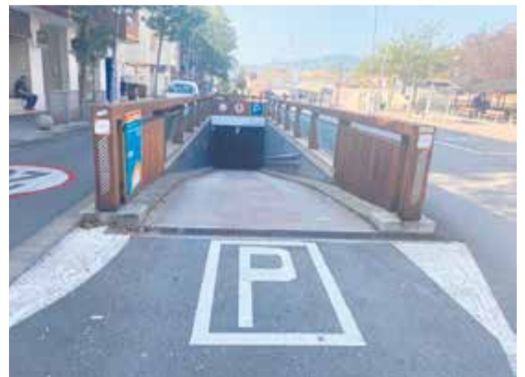
Una de les entrades al pàrquing des de la carretera de Sentmenat. || AJUNTAMENT
