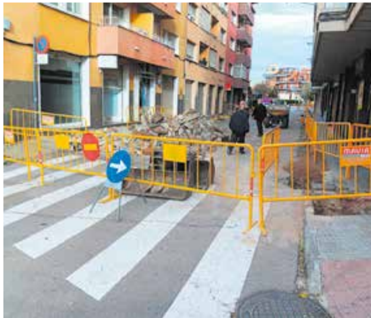
Les obres al carrer Barcelona entre Anselm Clavé i avinguda Sant Esteve. || J. RIUS
