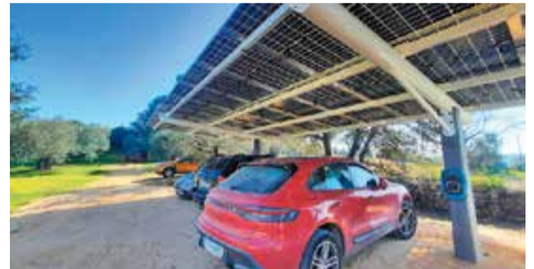
Una de les marquesines instal·lades per Urven Solutions. || CEDIDA
