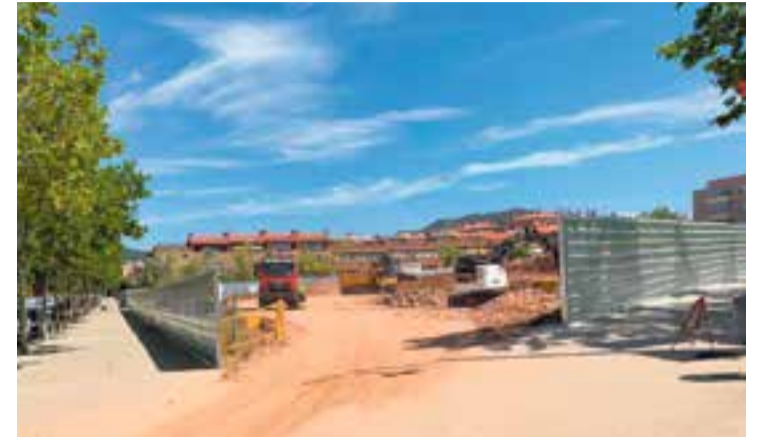
Imatge de l'accés al solar on tot just han començat les obres. || M. BARTRÉS
