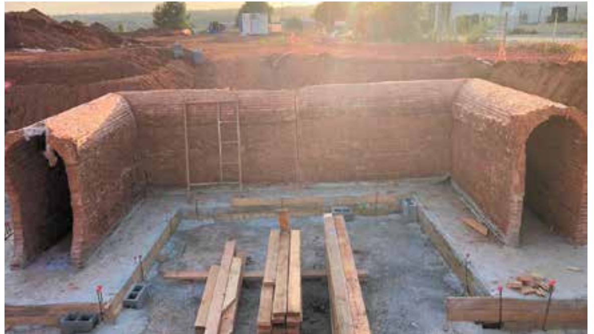
Aquest és l'aspecte del refugi que s'ha descobert arran de les obres de construcció de la plataforma logística. || J. J.
