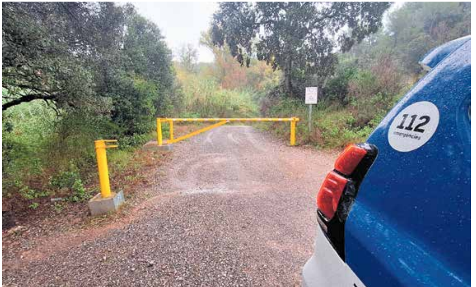
Des de fa tres anys es van instal·lar tanques a diferents passeres per restringir el pas de vehicles en cas de crecuda del riu. || CEDIDA
