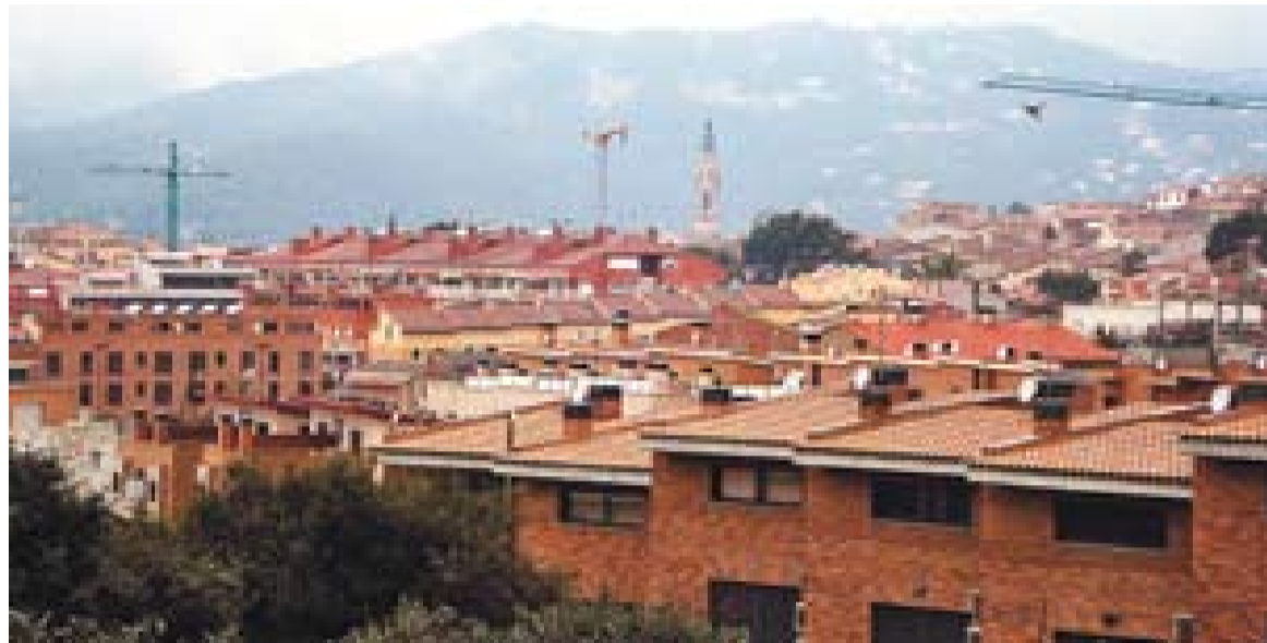
© Segons les previsions, les noves construccions s'aniran reduint encara més en els propers mesos. || J.R.
