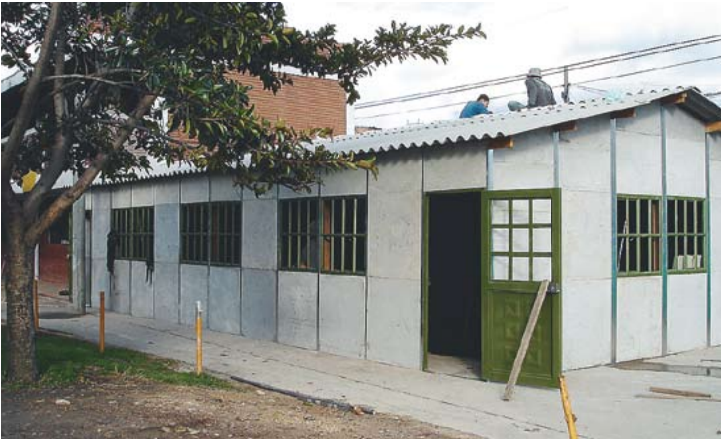
© Una de les dues aules en construcció de l'escola El Libertador del projecte Sala Gaudí de Castellar x Colòmbia. || CEDIDA
