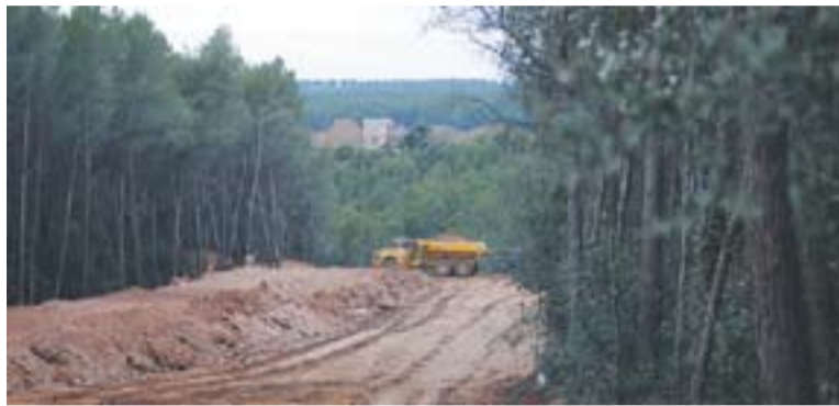
© Les obres als terrenys per on passarà el gasoducte. || J.G.
