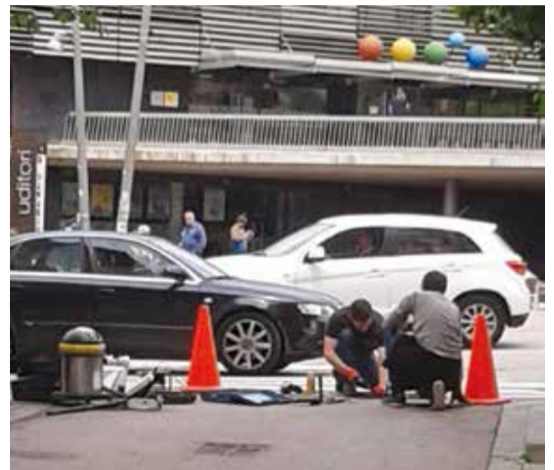
Pilones del carrer Sala Boadella || AJ. CASTELLAR
