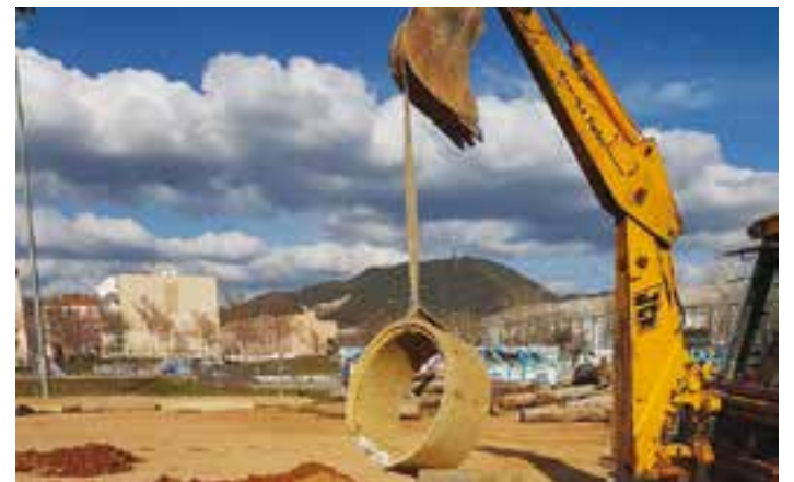
Obres de millora de l'Escola de trial 'El Bixu'. || CEDIDA
