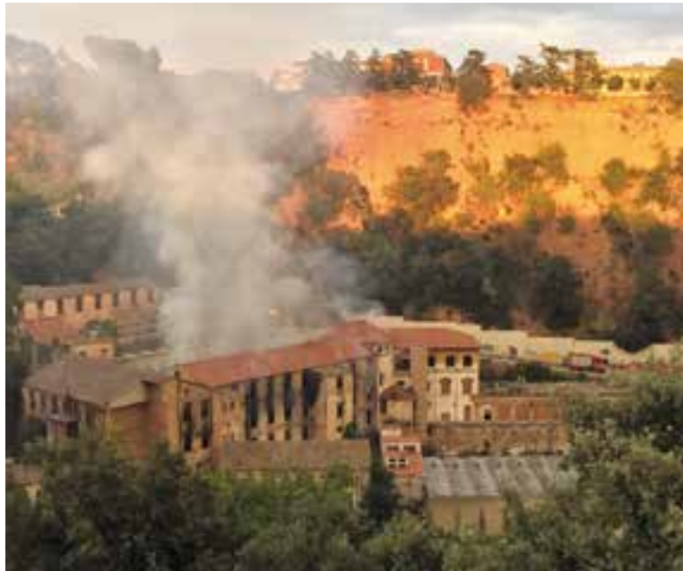
Les flames es van iniciar a la 3a planta de l'edifici. || F.CLUSELLAS
