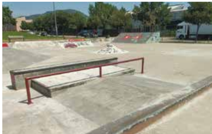
Aspecte actual de l'Skate park després de les obres que s'hi han fet. || CEDIDA
