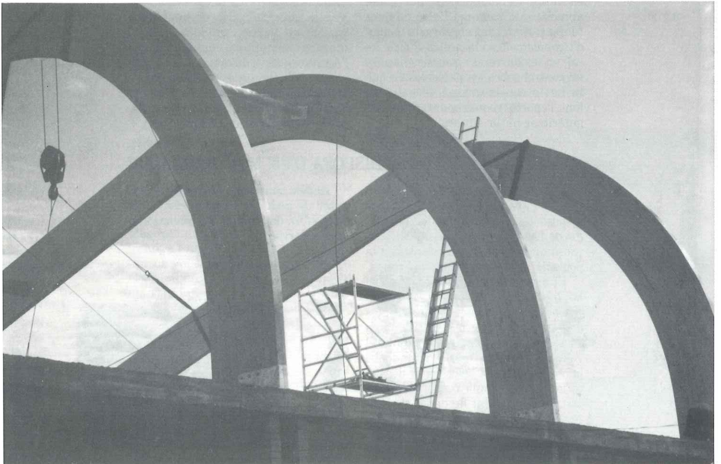
La col·locació de les bigues de fusta va ser força espectacular. L'empresa proveïdora té la seva seu a Tolosa de Llenguadoc (França)
