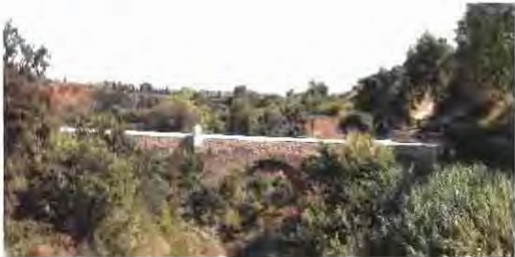
La remodelació del Pont Vell a l'riu Ripoll. L'ús dels blocs de pedra utilitzat originalment.
