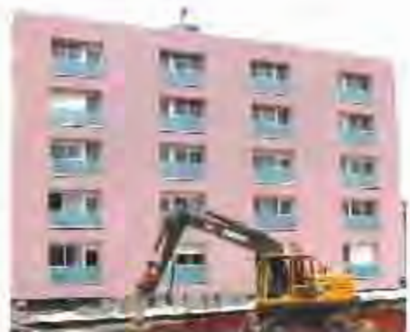
Recentment ha començat les obres de la zona de habitatges de lloguer.
