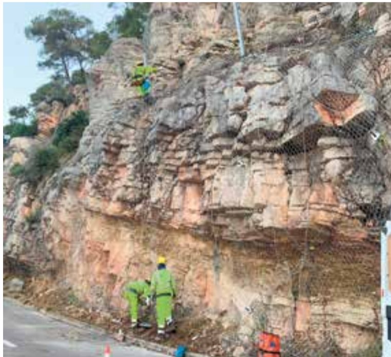
Treballs d'estabilització d'un talús de roca al carrer del Cim. || AJ. CASTELLAR
