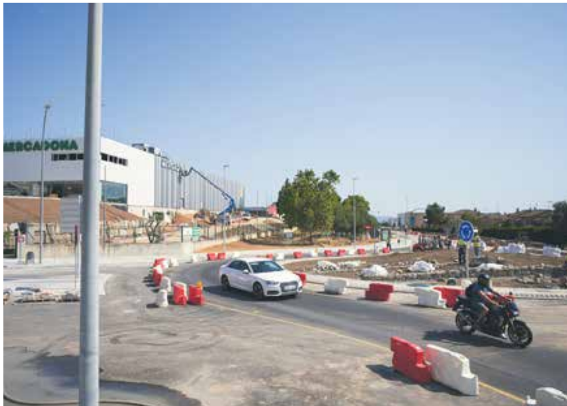
Imatge de les obres de la rotonda a principis d'aquesta setmana. A l'esquerra, el nou supermercat que s'està aixecant. || Q. PASCUAL
