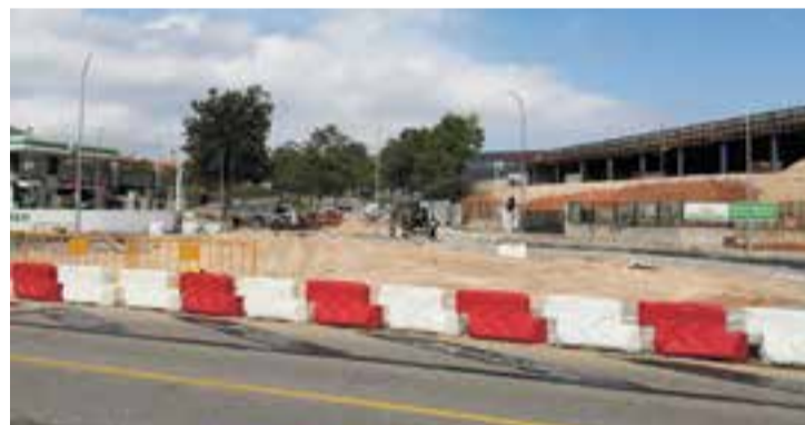
Les obres de la nova rotonda a la B-124 segueixen endavant. || J. RIUS
