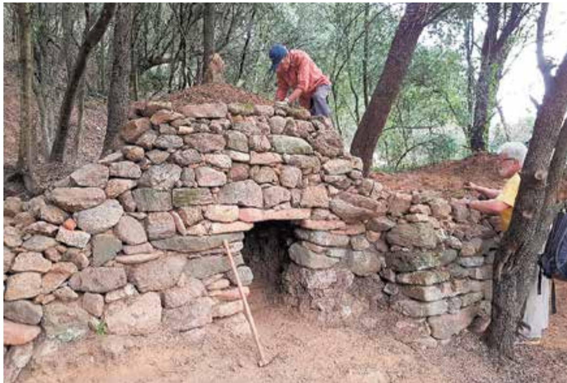
El grup de Recerca de la Pedra Seca del Centre Excursionista de Castellar treballant en la restauració d'una barraca. || CEDIDA
