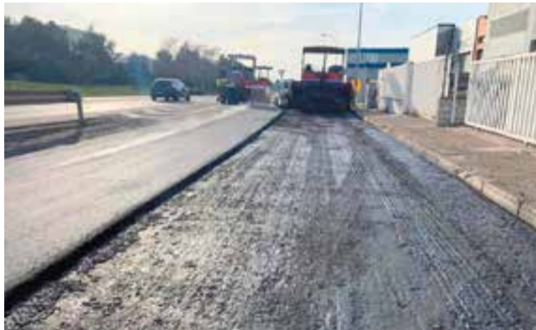
Entre les darreres obres, destaca l'asfaltatge del carrer Priorat. || AJUNTAMENT
