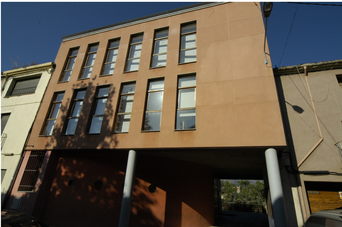
CAL BOTAFOC. Edifici Municipal de la Regidoria de Promoció Econòmica
