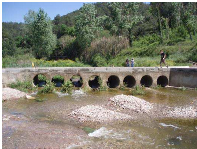
Passarel·la de l'AE de Les Arenes. 6/5/2007
