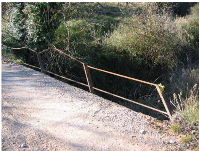
Baranes insegures del pont del camí de Vilaterçana. 3/1/2007
