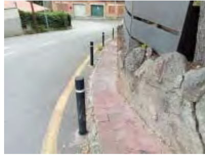
c. Canaleta (tram 1449-ZEG)
