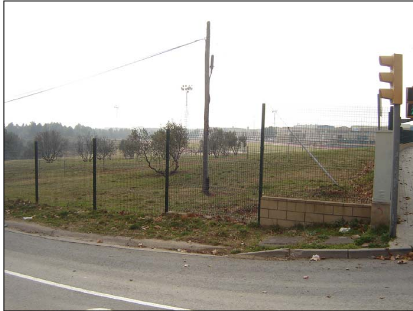
Foto 1: Vista general de la façana del solar estudiat.
