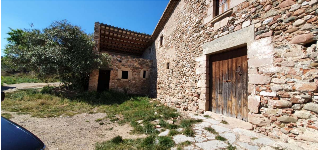
Façana principal i cos adossat de ponent (habitatge del pastor)
