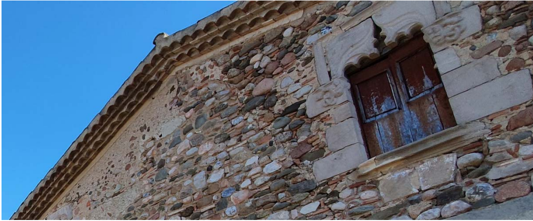
Detall coberta i finestral gòtic
