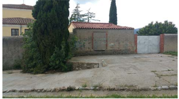
2 Accés secundari asfaltat per la banda est de la masia
