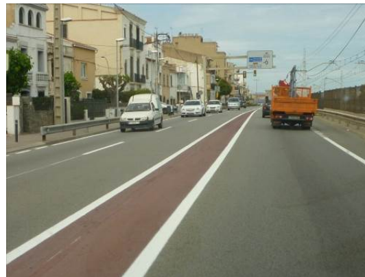
Imatge 4 Exemples de mesures de fàcil aplicació per l'estretament d'amples de calçada
