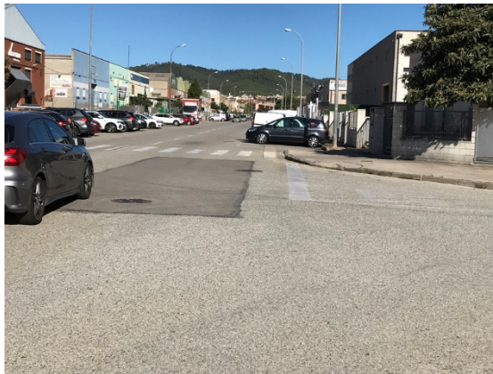
Imatge 154. Espai central de la cruïlla, massa obert per l'absència de marques viàries.
