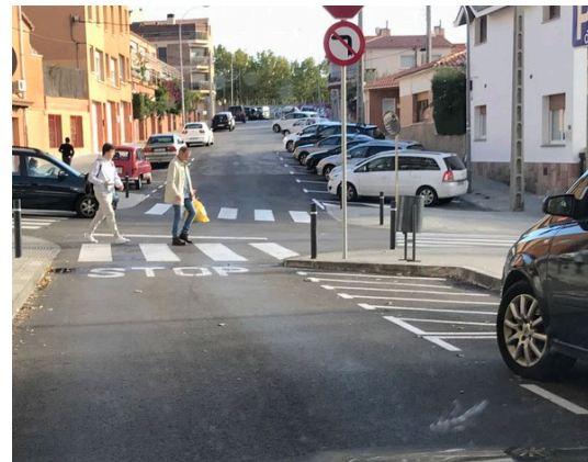
Imatge 86. S'ha modificat, la cruïlla passant de semibateria a aparcament en cordó a la dreta i afegint cordó a l'esquerra. S'ha aplicat mesures de millora de la visibilitat
