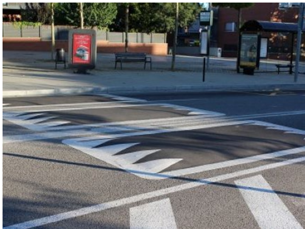
Imatge 157. Coixí berlinès pavimentat, no modular. Exemple de Sant Cugat del Vallès
