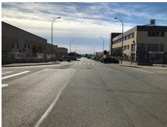
Imatge 154. Espai central de la cruïlla, massa obert per l'absència de marques viàries.
