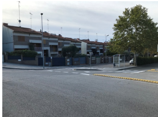
Imatge 141. Vegeu l'anella amb tot l'ample disponible. Indueix a velocitats interiors inadequades i a desplaçaments laterals.
