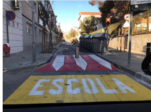
Imatge 171. Pas elevat existent a l'entrada de carrer del Doctor Portabella.
