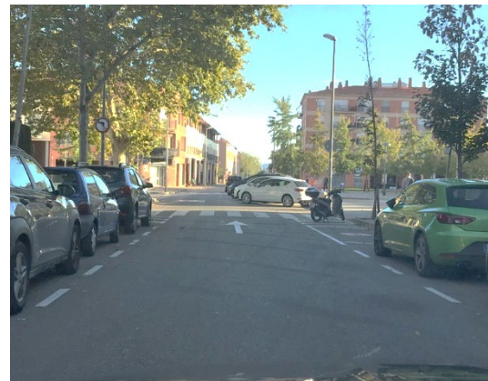
Imatge 86. S'ha modificat, la cruïlla passant de semibateria a aparcament en cordó a la dreta i afegint cordó a l'esquerra. S'ha aplicat mesures de millora de la visibilitat
