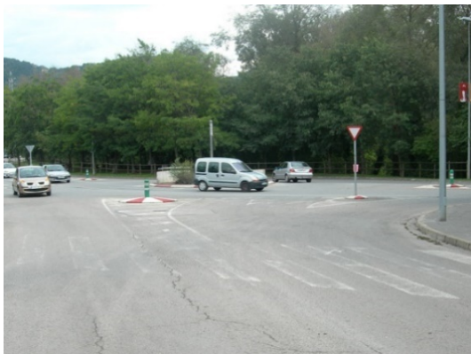
Imatge 10 Senyalització horitzontal o vertical en estat deficient
