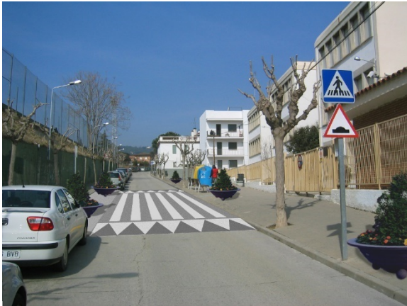
Figura 84 Fotomuntatge proposta de carrer amb paviment únic i preferència per a vianants. Velocitat límit de 20 km/h.
