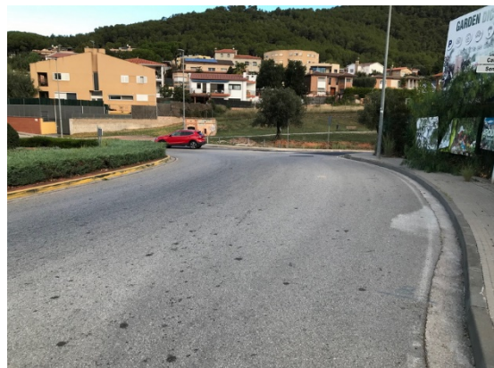
Imatge 141. Vegeu l'anella amb tot l'ample disponible. Indueix a velocitats interiors inadequades i a desplaçaments laterals.
